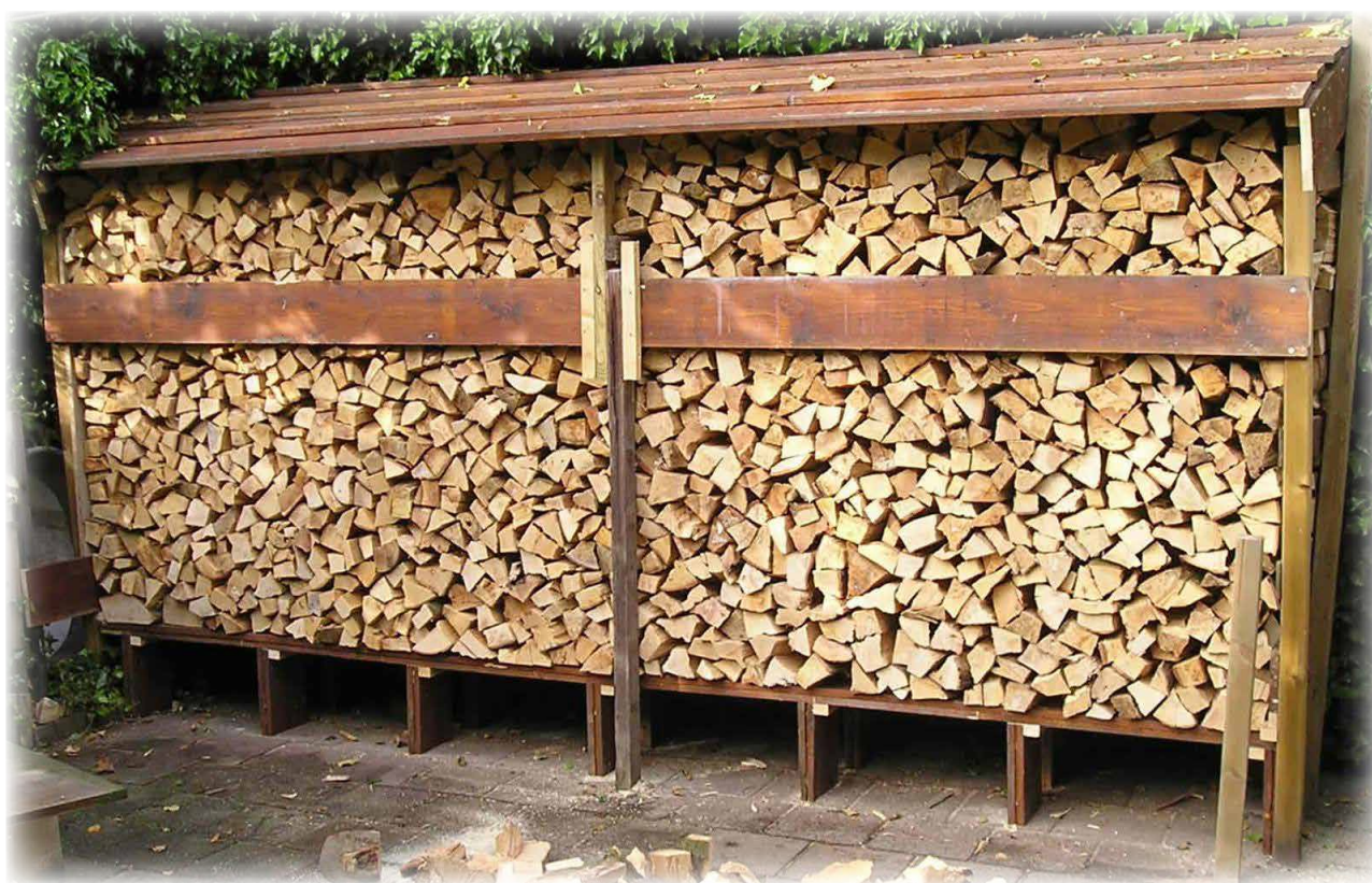
Installation de séchage, soulevée à environ 30 cm du sol avec un espace entre les tas de bois
